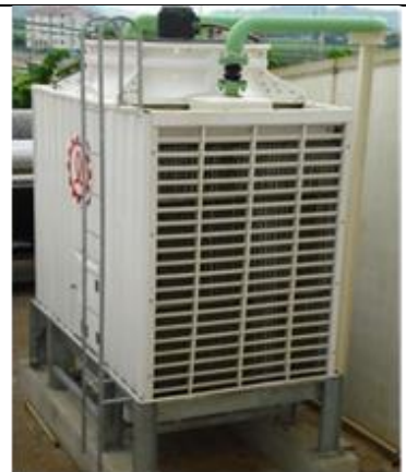
รูปที่ 2.14 Cross Flow Cooling Tower
